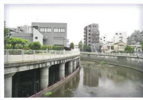
⑥地下調節池の取水口
