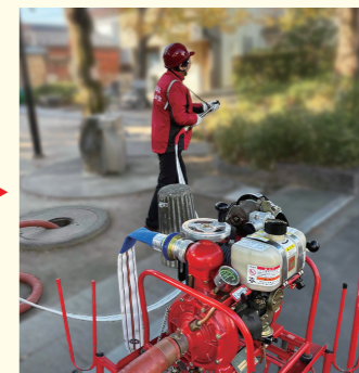
③放水ホースをつなぎエンジン始動
